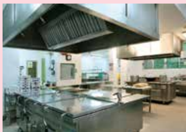
食品厨房設備
