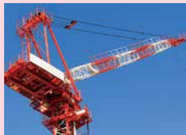
工事用クレーン
