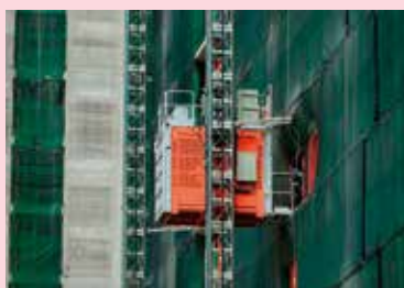
工事用エレベータ・リフト
