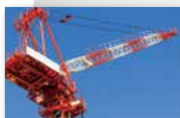
工事用クレーン
