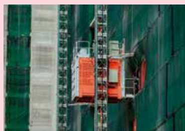
工事用エレベータ・リフト
